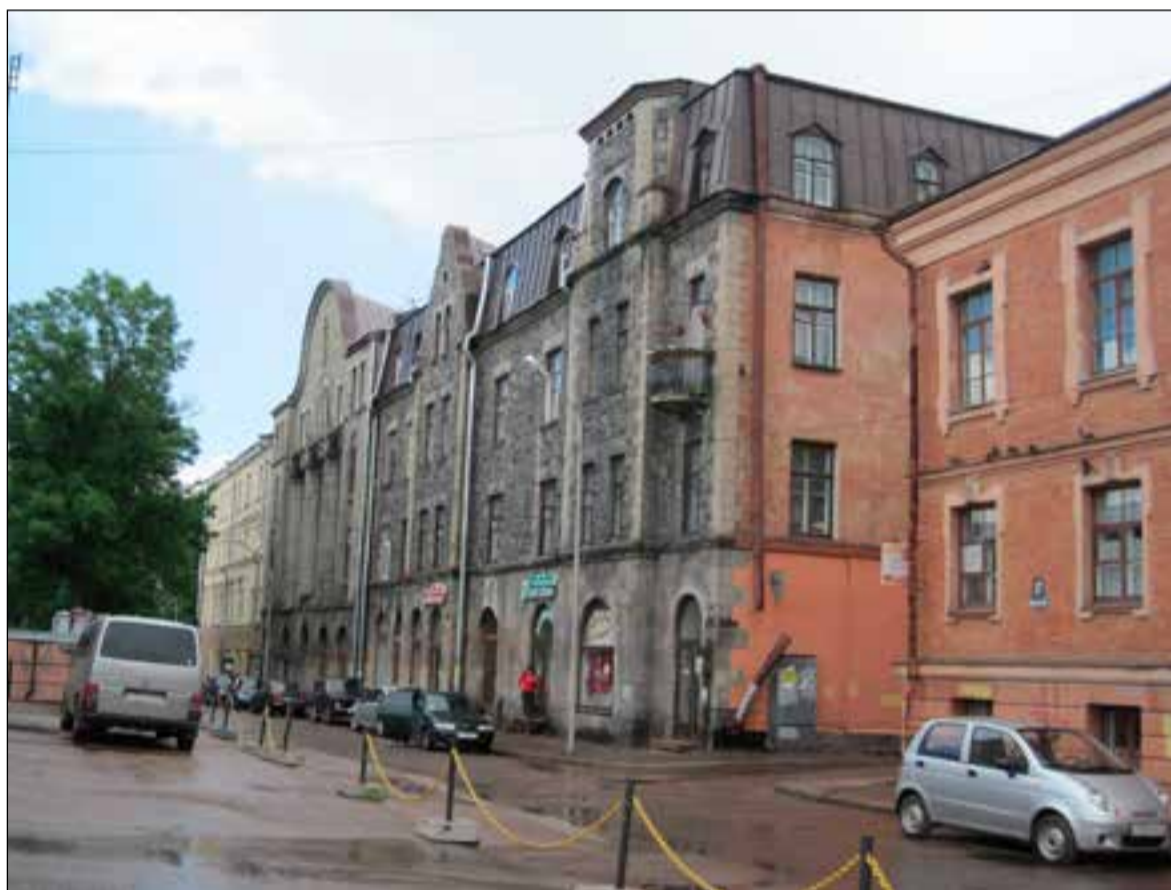
De stiliga fasaderna vid Norra Vällen 21 och 19.
