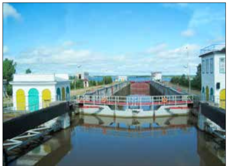
Den norra ändan av Stalinkanalen
