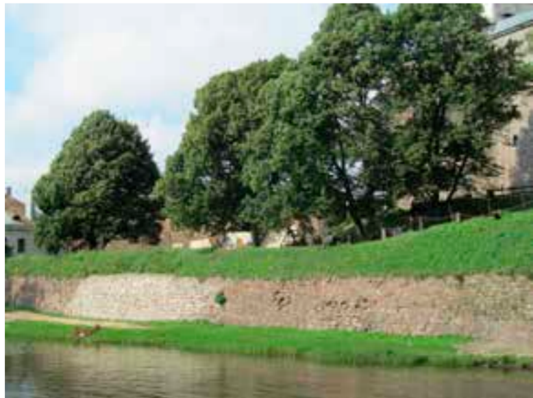
Raset i stenvallen hade reparerats.
