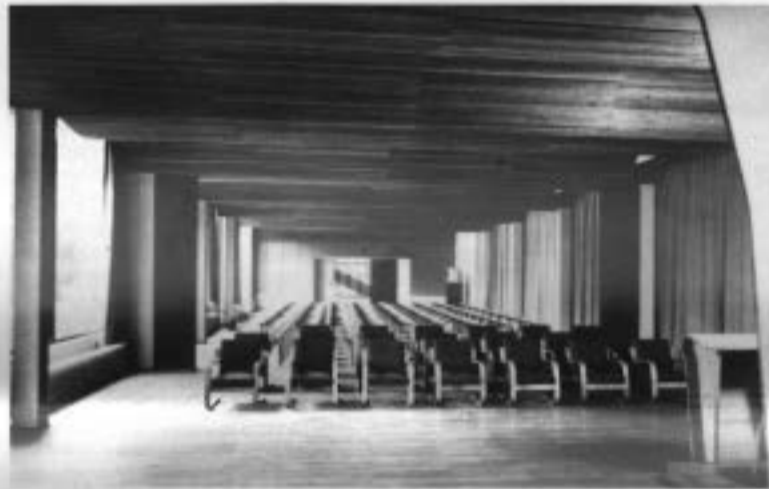
Den berömda föreläsningssalen med det "undulerande" taket.
