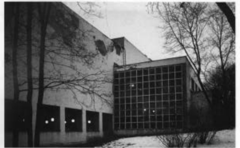
Glasväggen efter reparationen 1996.
