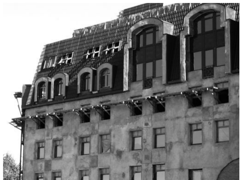
Blir det någonsin färdigt? Viborgsresenärer har under de senaste 15 åren undrat över vidundret vid Salutorgets och Salakkalahtigatans hörn. Nu har det tagit ett skutt framåt. Om huset blir färdigt skall det bli ett kongresshotell, säger man.
