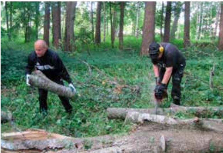
De fällda träden avlägsnas från terrängen.
